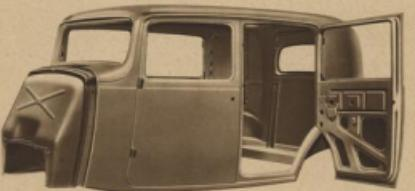
Carrosserie "Tout Acier Monoplace". On remarque la solide structure des portes et les montants entièrement métalliques.
